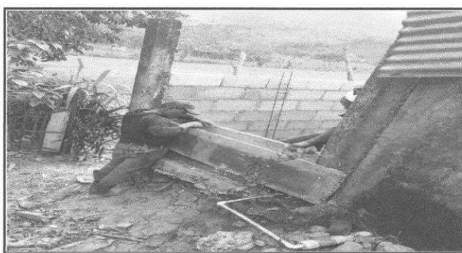
Foto 6: Se observa el muro perimetral de la escuela.
