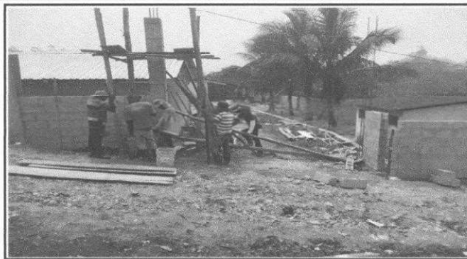
Foto 2: Se observa del porton de la entrada principal.
