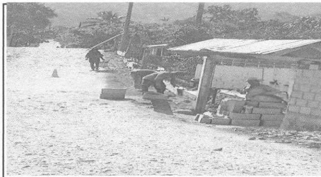
Foto 4: se observa la construcción del muro perimetral.
