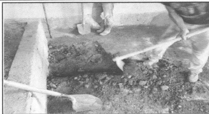
Foto 1: Se observa el inicio de la construcción de la cocina.
